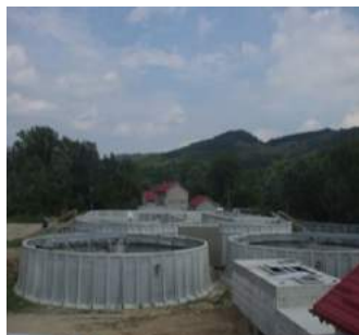
CL6-Decantor secundar Pucioasa-probe etanșeitate
