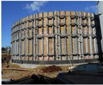
CL8-SE Găești Decantor Secundar nr. 1-Cofrare pereți
