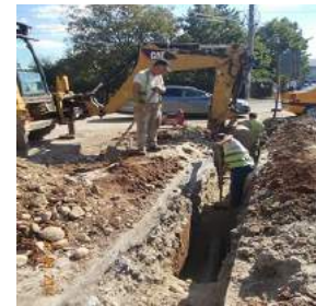
CL3-Str. Calea Domnească (Teiș-Stelea)-Acoperire conductă cu nisip
