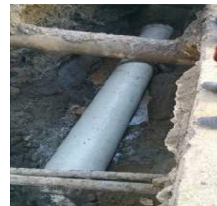
CL5-Str. Cpt. Pantea-montat conductă canalizare
