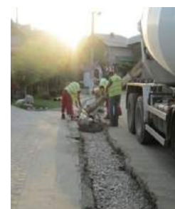
CL7-Cartier Miculești turnat beton
