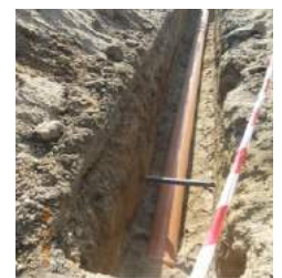
CL9-Str. Câmpului-Montaj conductă
