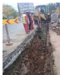
CL7-Str. Republicii (DN71)-montat conductă canalizare
