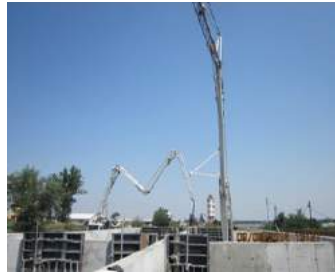
CL8-SEAU Titu-Bazin Aerare-Betonare pereți
