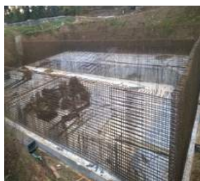
CL4-Ob. 7 Decantoare primare-Finalizare armare pereți
