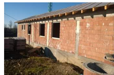
CL4-Ob. 28 Clădire administrativă și laborator-montaj termopane
